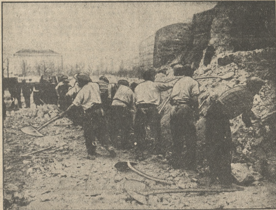
Reszty murów fortyfikacyjnych Paryża padają obecnie pod uderzeniami oskardów rzeszy robotników którzy w ten sposób znajdują pracę, o jaką i we Francji trudno. Stolica świata doświadczyła w czasie wielkiej wojny, że mury fortyfikacyjne wobec armat, strzelających z odległości kilku mil. są bezcelowe, a tylko hamują rozbudowę.
