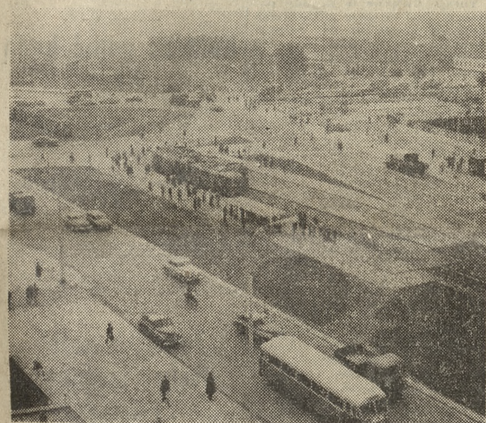
Nowe rondo komunikacyjne na placu Zawiszy w Warszawie oraz przebudowana ul. Towarowa, przekazane do użytku 4 bm. CAF — fot. Sokolowski
