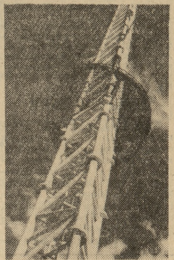
Model nowego maszyn telewizyjnego, budowanego pod Śremem. Na targach jest on prezentowany w mniejszej skali 1:10. Normalna wysokość budowli wynosi 200 m!
