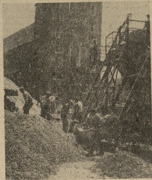
Przebudowa rynku krakowskiego weszła w drugie stadium — rozpoczęło betonowanie powierzchni, na której będą układane płyty z piaskowca.
