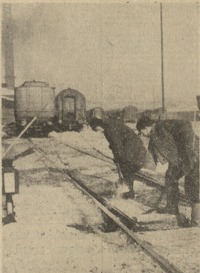
Mroźny znowu łęgi. Okresowe opady śniegu także utrudniają pracę na kolei. Na zdjęciu: czyszczenie zwrótnic na stacji Poznań — Główny. CAF — fot. Sokolowski
