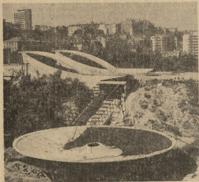
W Warszawie trwa budowa nowych przystanków kolei elektrycznej na trasie linii średnicowej. Na zdjęciu: budowa dachu pawilonu wejściowego przystanku Skarpa. CAF — fot. Szyperko
