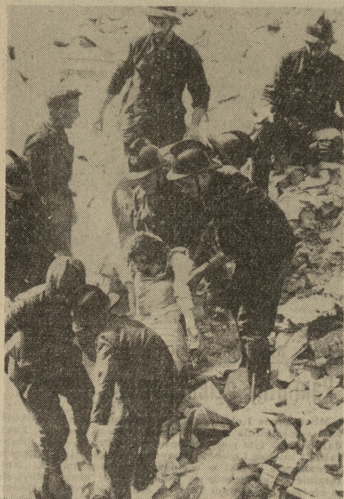
W Brukseli zawałił się 4-piętrowy biurowiec Ministerstwa Spraw Ekonomicznych, grzebiąc pod gruzami kilkudziesięciu urzędników tej instytucji. Śmierć poniosło 15 osób. Na zdjęciu: strażacy odkopują spod gruzów zwłoki ofiar katastrofy.
