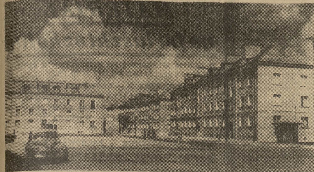
Osiedle mieszkaniowe Winoqrady w Poznaniu po kilku latach świecenia gołymi cegłami doczekało się wreszcie tynkarzy. Roboty nie przebiegają w zbyt szybkim tempie, ale jest nadzieja, że wkrótce wszystkie nowe domy pokryte zostaną kolorowymi tynkami. Szkoda tylko, że przy okazji nie otynkowano kilku starych domów przy ul. Owsianej, które szpecą wygląd całego osiedla. Fot. — K. Przychodźki
