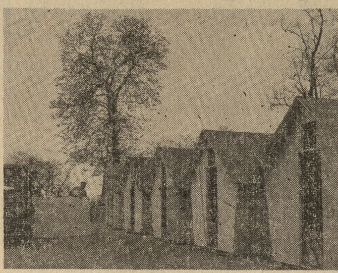
Montaż domków campingowych dla Dziwnowa. CAF — fot. Kondracki
