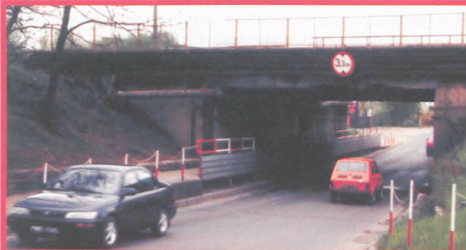
Kłopotliwy wiadukt przy ul. Powstańców Wlkp. Dobrze widoczny znak 3,3 m. Czy rzeczywiście ?
