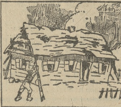
a tak po 8 latach wygląda dom nieimpregnowany zjedzony przez grzyb drzewny.
