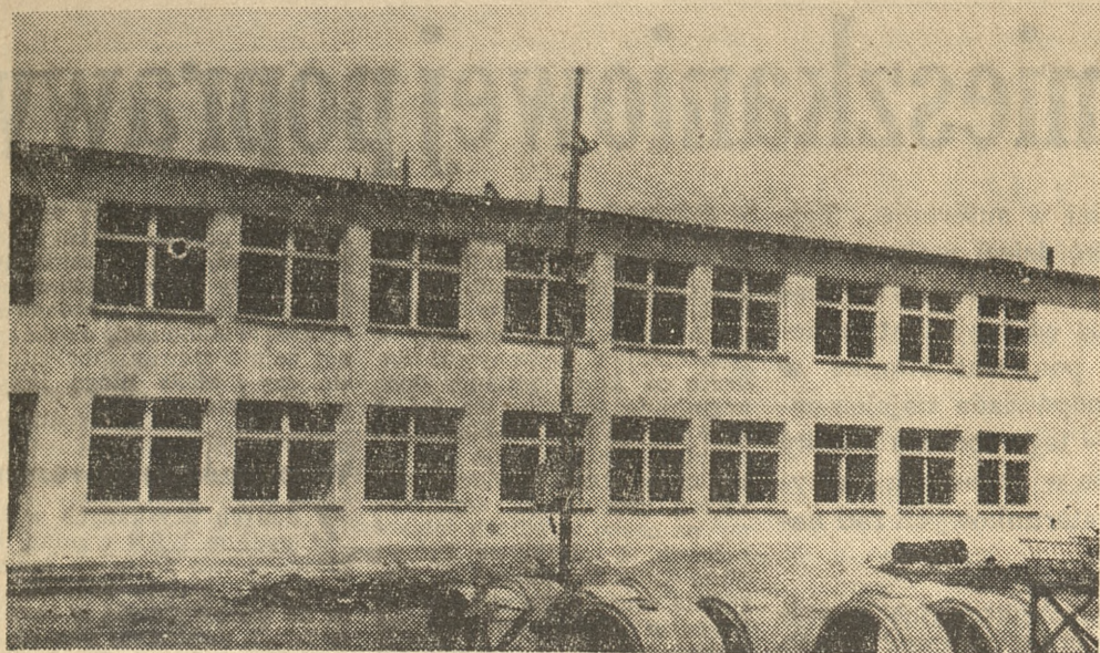
Szkoła podslawowa w Kofuni pow. Słupca (w budowie)
