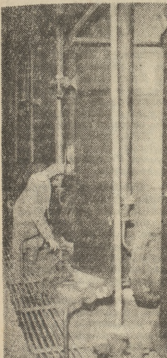
Zakłady Koksochemiczne „Hajduki” w Chorzowie przerabiają smołę koksowniczą i benzol surowy na benzen czysty i motorowy, tylon, ksylon oraz szereg produktów smołowych. Znaczną część produkcji Zakłady przeznaczają na eksport. Dla uczczenia zbliżających się wyborów oraz święta 1 Maja załoga zakładów podjęła liczne zobowiązania produkcyjne, wartość których wynosi 1,6 mln. zł. Na zdjęciu: Fragment oddziału destylacji fenolu. Przy pracy — destylator Marian Ziemia.
