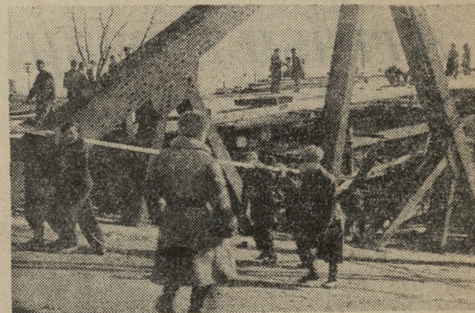
Luty 1945 r. Żołnierze radzieccy pomagają przy budowie zburzonego mostu na Wiśle.
