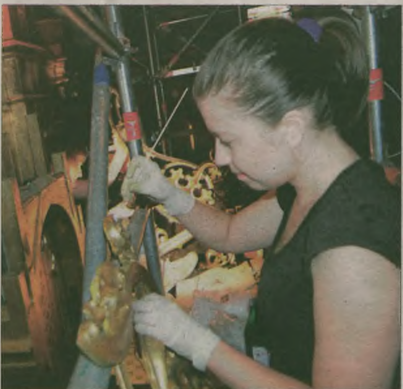
Największego nakładu pracy wymagało żmudne czyszczenie ze zmurzałej farby i przygotowanie podkładu pod nową.
