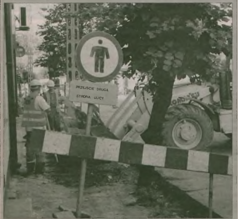
Remont drogi rozpoczęto od wymiany chodników.
