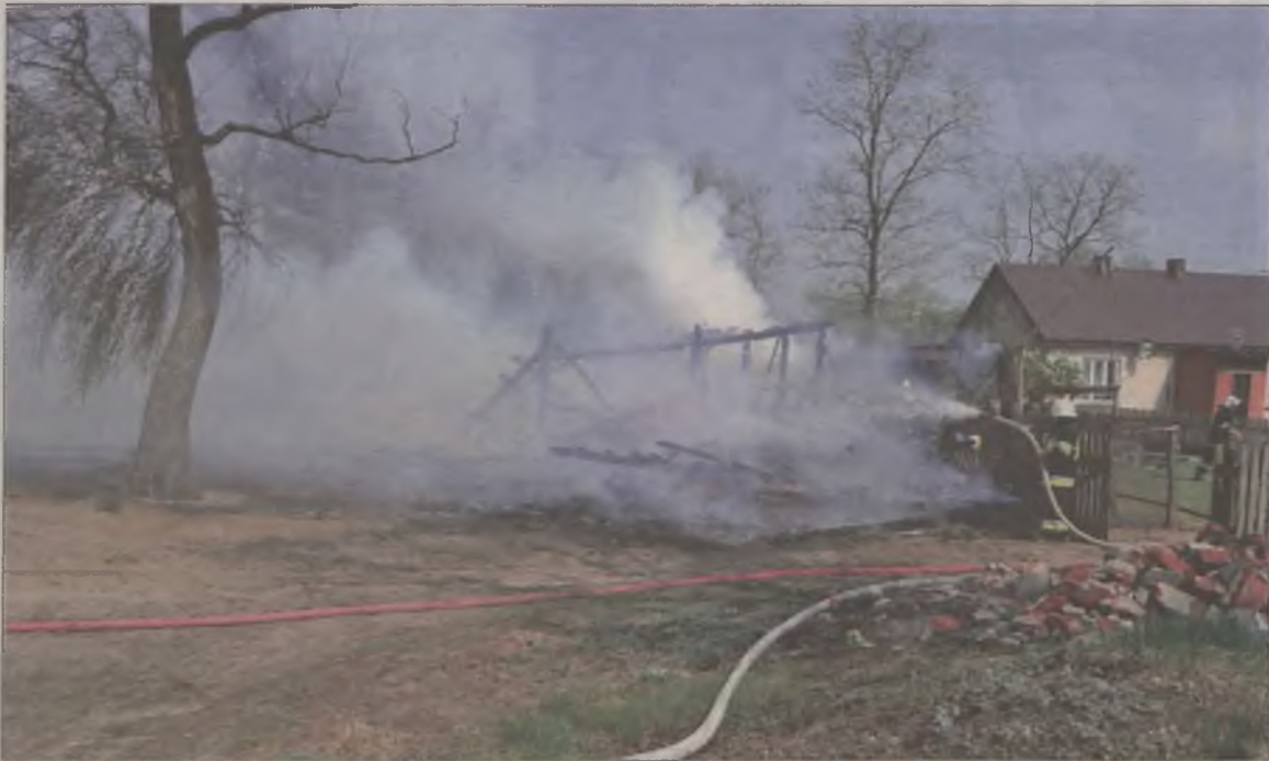
Do pożaru drewnianej stodoły w gminie Przykona doszło z winy właścicieli.
