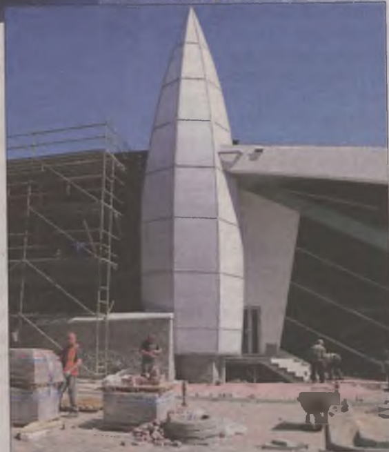
W nowych obiektach termalnych i na zewnątrz, trwają intensywne prace wykończeniowe.
