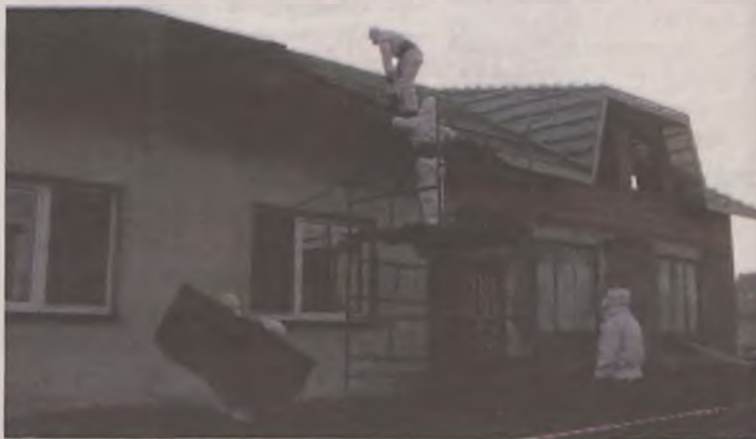
W złożonych wnioskach mieszkańcy powiatu najczęściej wnioskowali o demontaż i wywóz płyt eternitowych.
