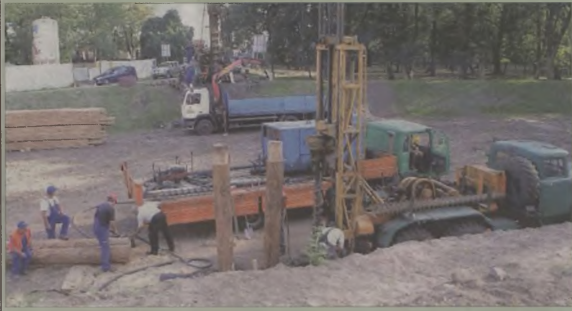
Do budowy mostu użyto specjalistycznego sprzętu.
