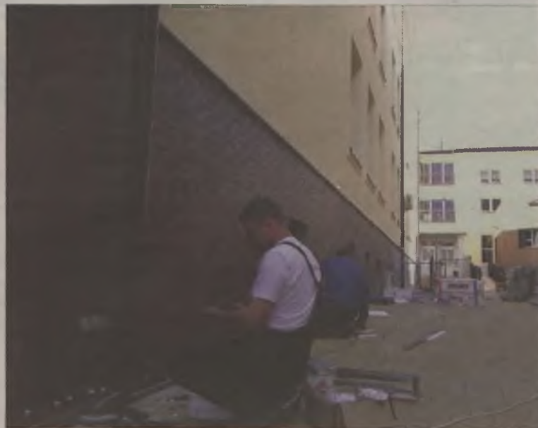
Ostatnie prace przy ociepleniu budynku Gimnazjum nr 2
