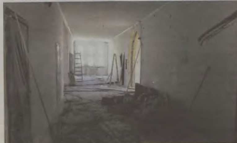
Remont korytarza w Gimnazjum nr 2
