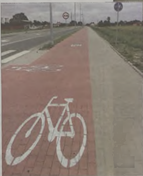
Wzdłuż drogi zbudowano bezpieczną ścieżkę rowerową i chodnik
