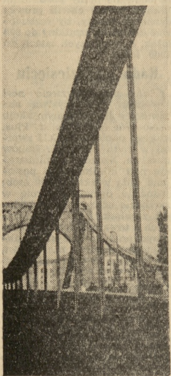
Fragment mostu Grunwaldzkiego we Wrocławiu.
