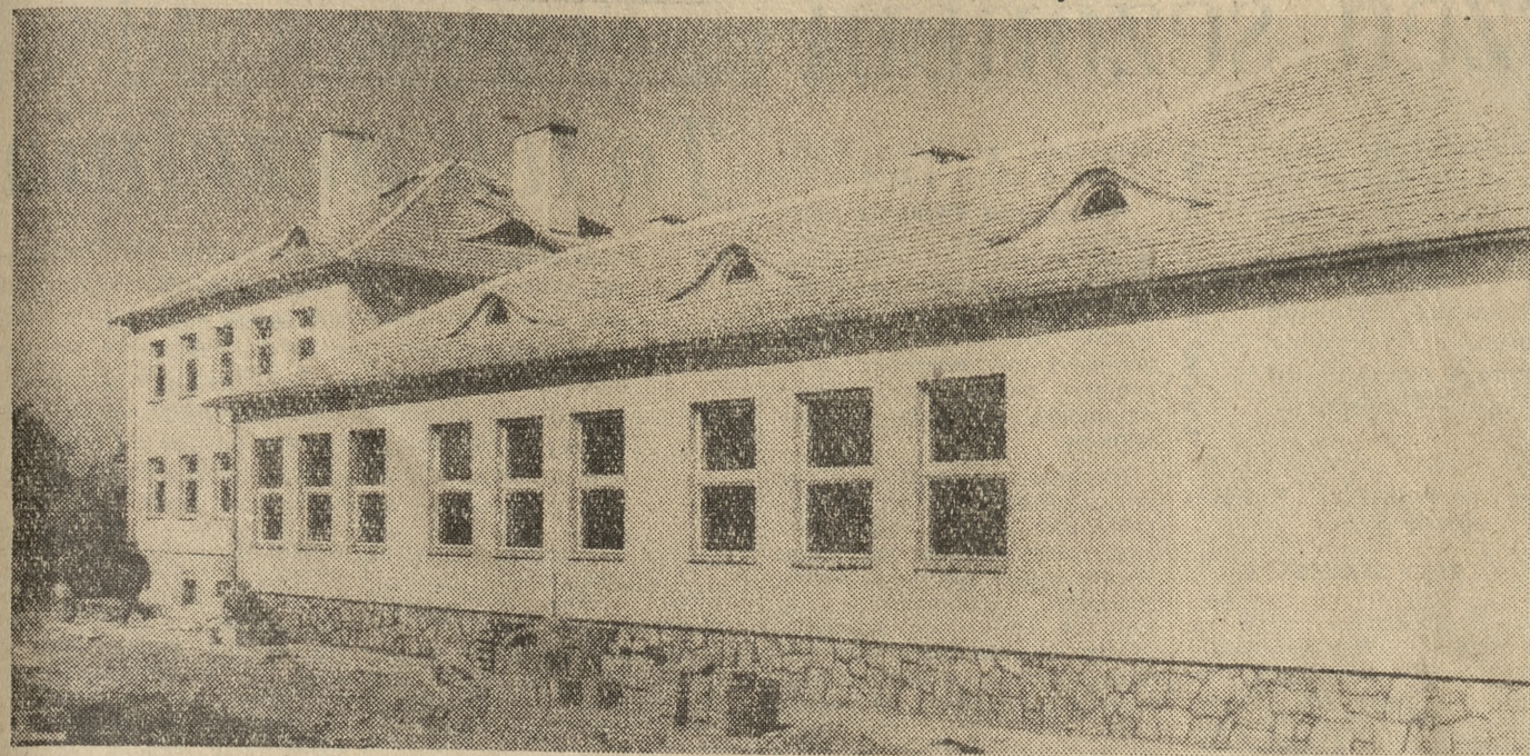
...szkoła wiejska w Starej Krobi (pow. Gostyń) wkrótce zapełni się młodzieżą. Jeszcze wiosną stały tu jedynie fundamenty, a dziś — prace na ukończeniu.
