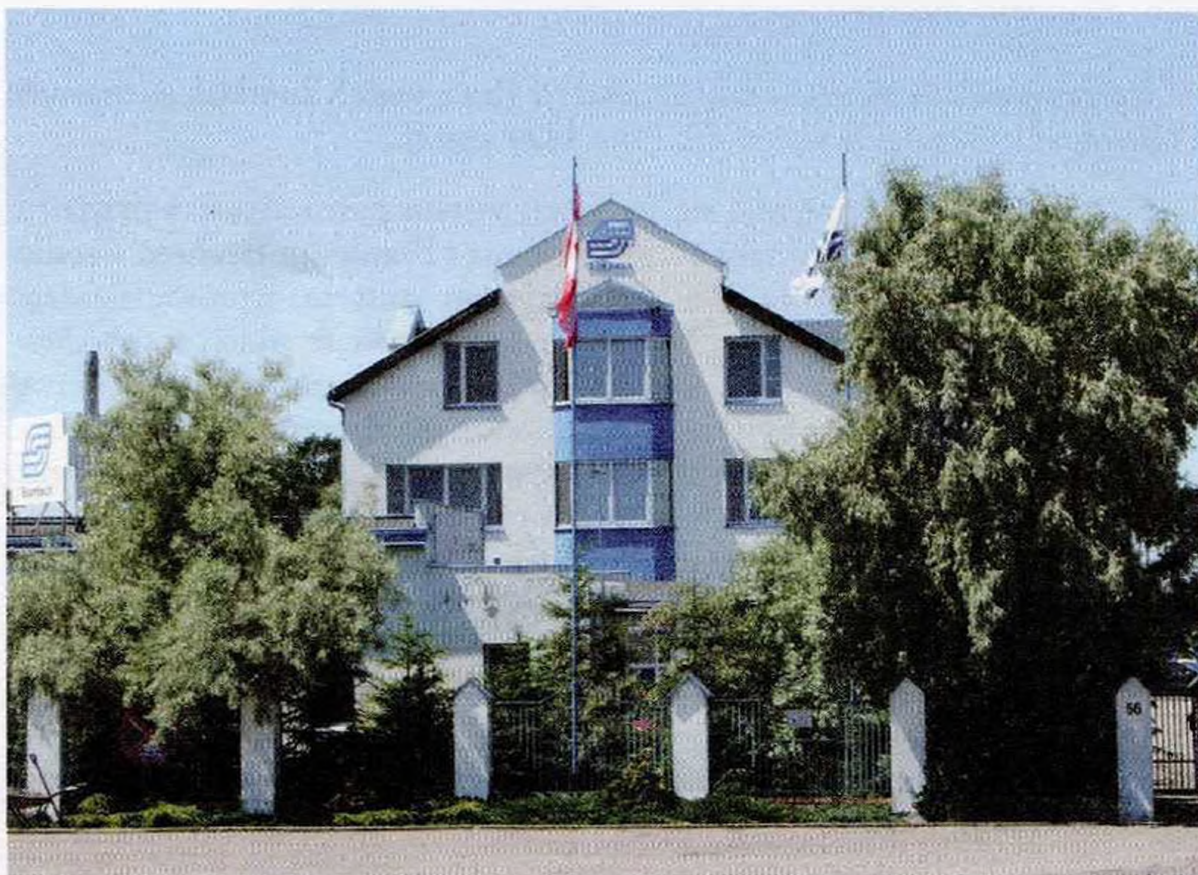
Budynek administracyjny firmy SCANBECH w Nowym Tomysłu
