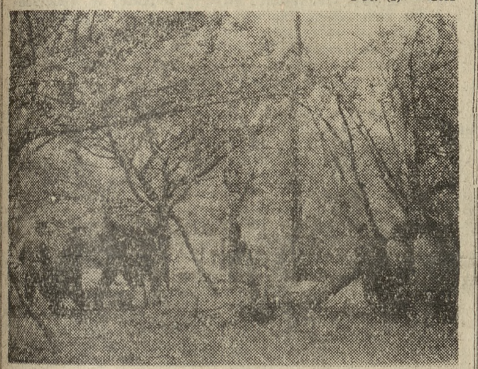
W wioskach i miasteczkach Rzeszowszczyzny trwają prace nad odbudową zniszczonych przez huragan domów i zagrod wiejskich. Ratowanie powalonych przez huragan drzew owocowych w gromadzie Niechóbrz.
