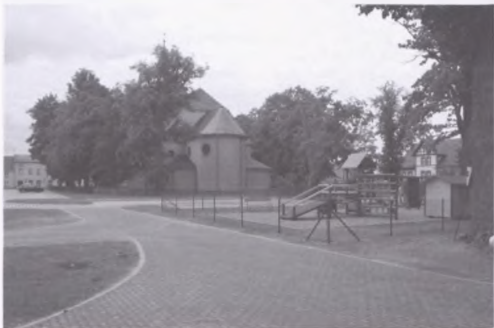
Plac Kościelny w Borui Kościelnej – po zakończeniu inwestycji
