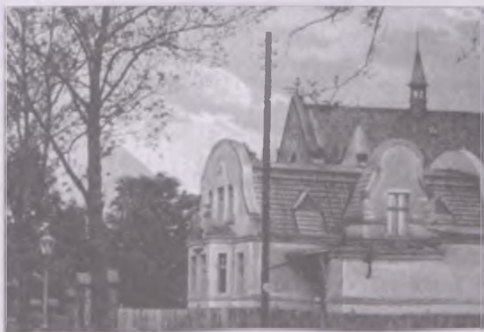
... przyglądamy się budowie probostwa ...
