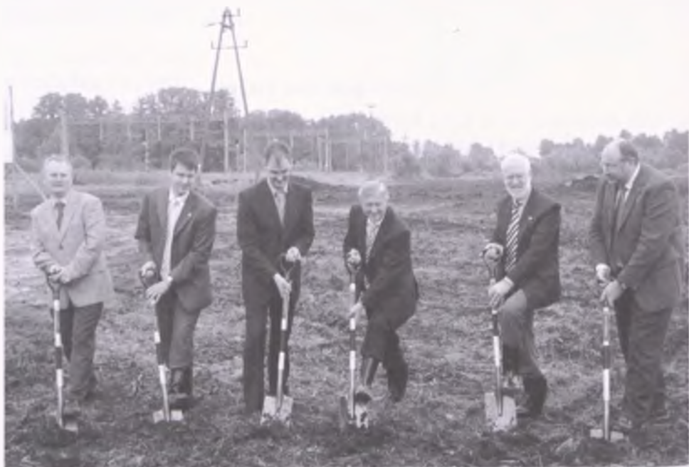
Rozpoczęcia budowy dokonano poprzez symboliczne wykopanie pierwszych łopat ziemi na terenie budowy zakładu
