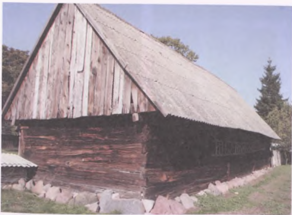
Budynek gospodarczy w Przylęku
