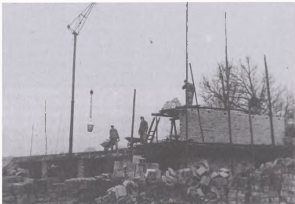
Gmach biblioteki publicznej w budowie (1964 r.)
