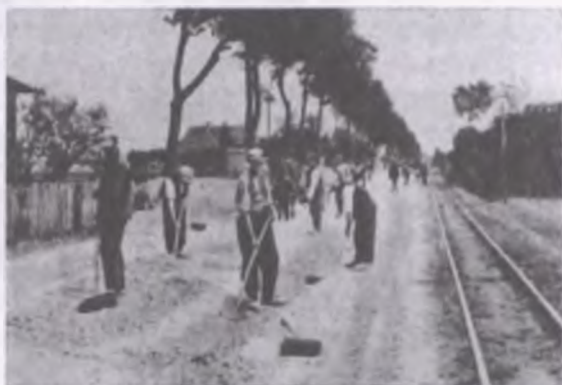
Prace drogowe na szosie państwowej odcinek Opalenica-Lwówek
