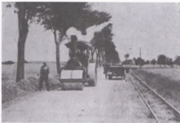
Walcowanie szosy na odcinku Opalenica - Lwówek
