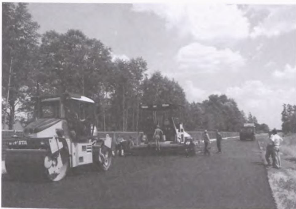
Budowa nowotomyskiej obwodnicy - lipiec 2006 r.
