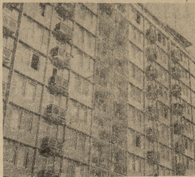
Fasada domu zbudowanego całkowicie z elementów prefabrykowanych z gotowym, kolorowym tynkiem.
