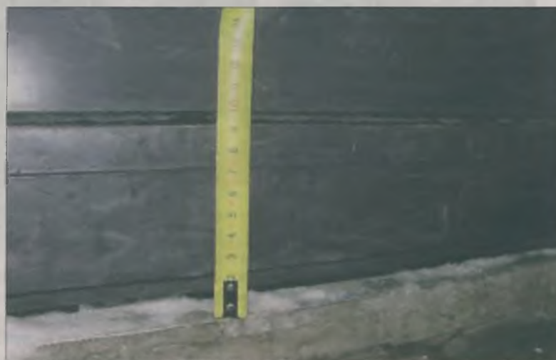
Wyraźna szczelina pomiędzy progiem i dolną krawędzią drzwi która wynosi ok. 20 mm
