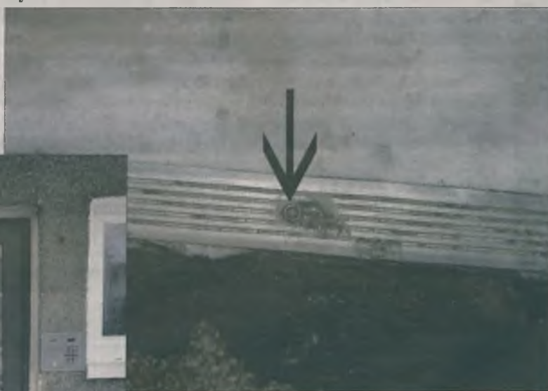
Wyraźna szczelina pomiędzy progiem i dolną krawędzią drzwi która wynosi ok. 20 mm
