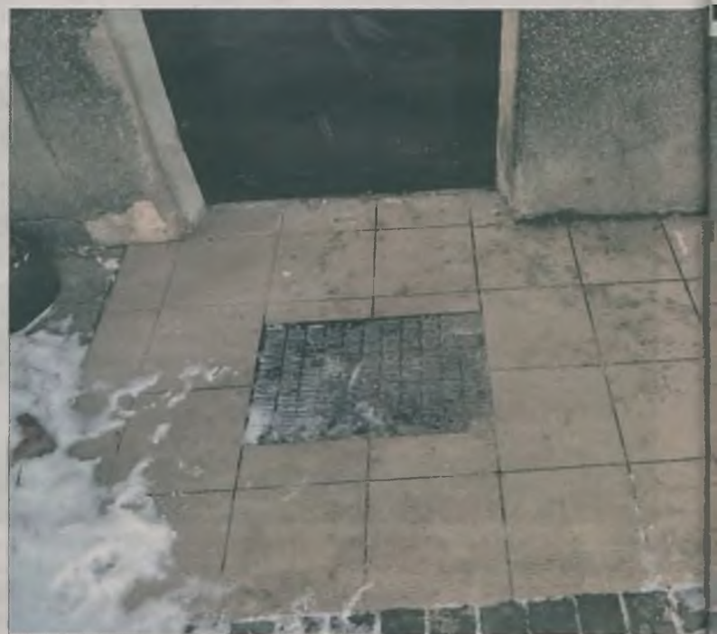
Wyraźna szczelina pomiędzy progiem i dolną krawędzią drzwi która wynosi ok. 20 mm
