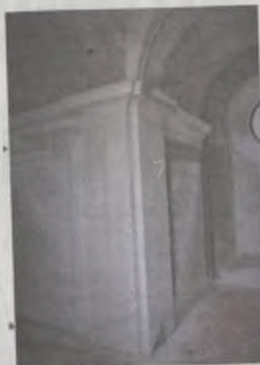
We wnętrzu położono nowe tynki.
