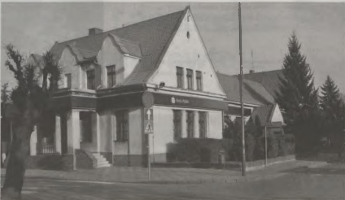
Opuszczenie przez placówkę bankową stuletniego budynku grozi, że będzie to kolejny etap podupadania ulicy Żeromskiego.
