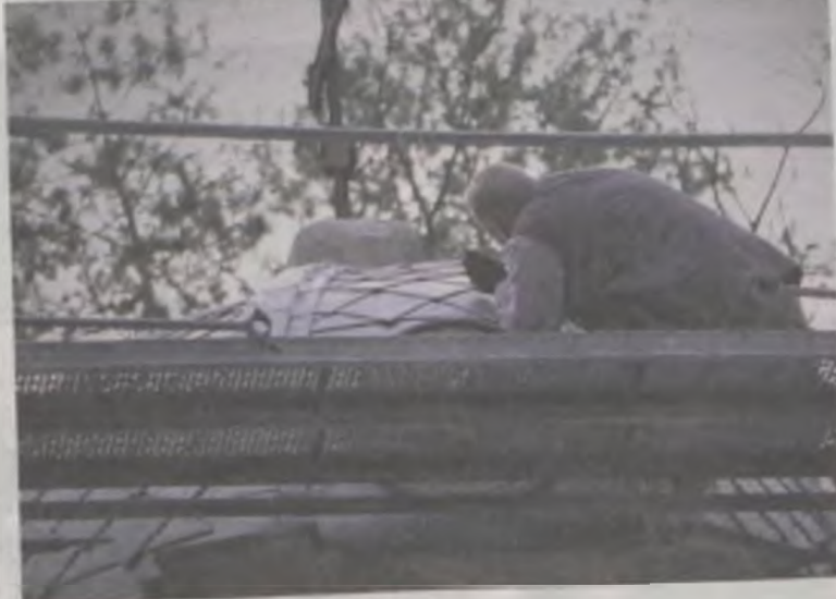
Wymiana dachu uchroni budynek przed zaciekami i wilgocią.
