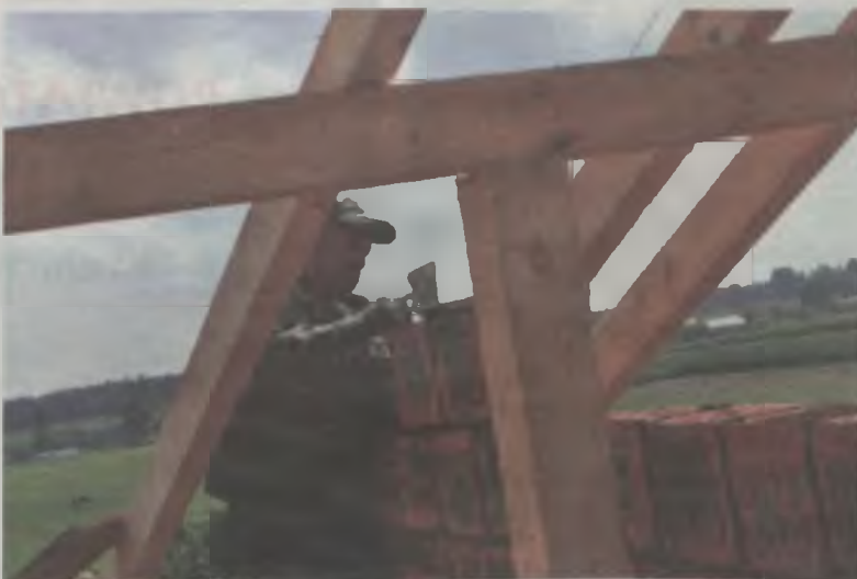
Właściciel domu w Miłaczewku Jan Płóciennik także zakasał rękawy do pracy przy naprawie dachu.
