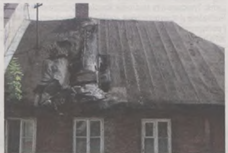
Dach domu krytego papą przy dobrskim rynku.
