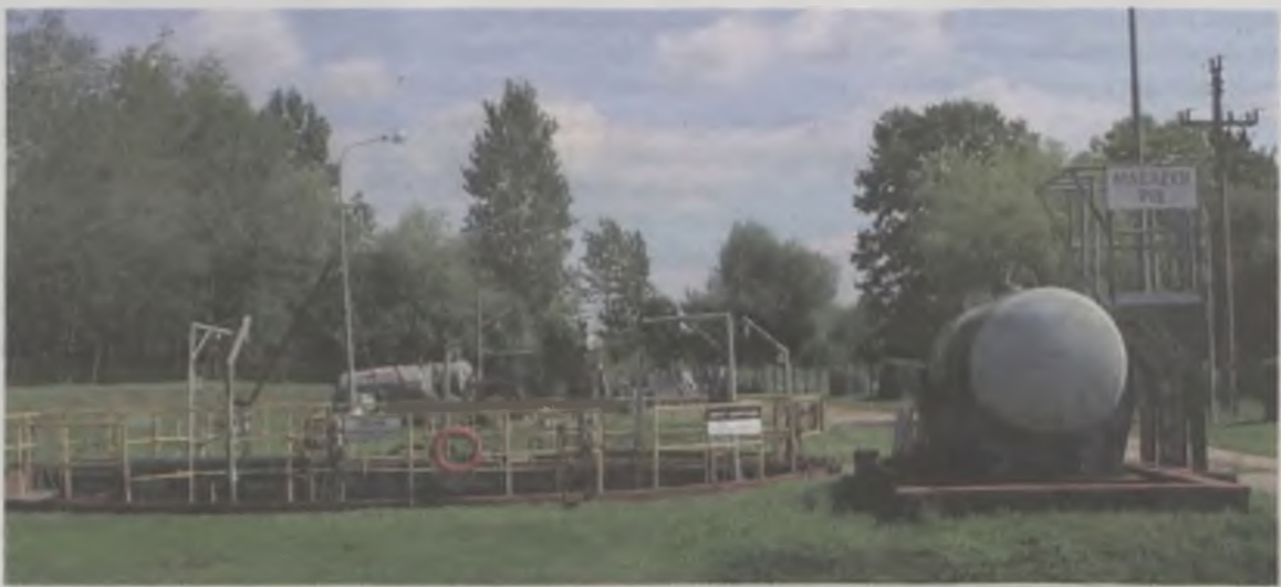
Oczyszczalnia pracuje na całych obrotach. Co się stanie jak ubojnia zwiększy produkcję nie budując własnej oczyszczalni?
