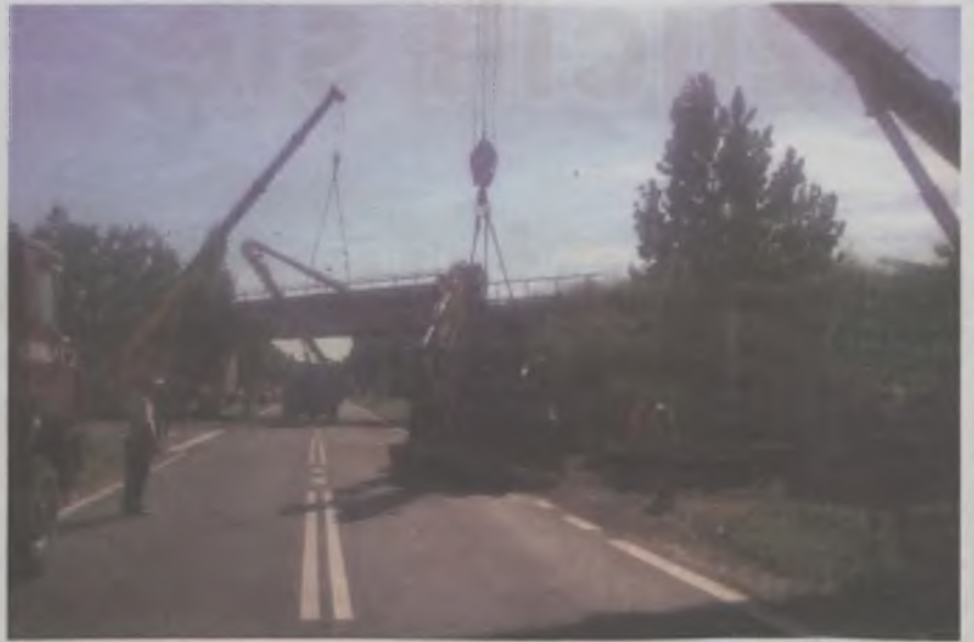
Około godziny 15.00, dźwig załadował koparkę na lawetę.
