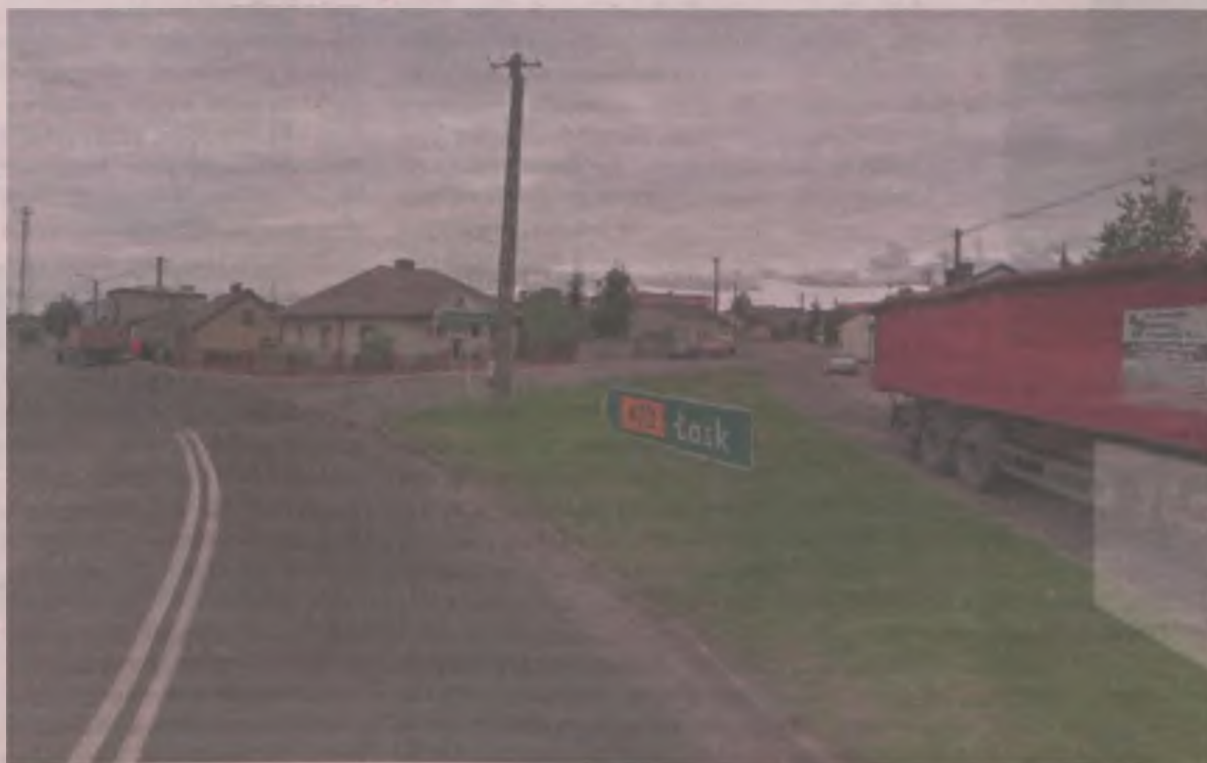
Przebudowa skrzyżowania na drodze wojewódzkiej w Uniejowie jest kolejnym etapem modernizacji tego ważnego traktu komunikacyjnego, łączącego północ z południem. Zdjęcie google.pl
