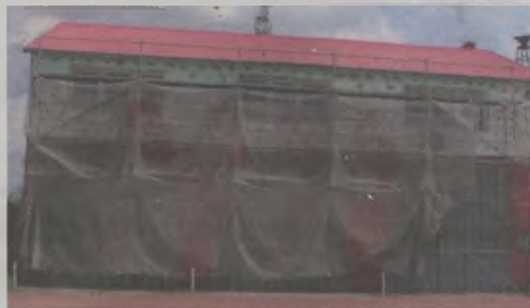
Nowych bram jeszcze nie widać, ale jak twierdzi komendant Dulin już są zamontowane.
