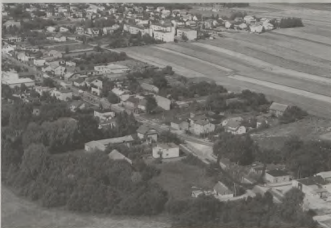
W zaznaczonym na zdjęciu miejscu powstanie rondo u wylotu drogi krajowej w kierunku Sieradza.
