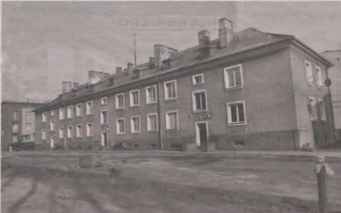
Prezentowany na zdjęciu blok nr 2 przy ulicy Orzeszkowej w Turku, podobnie jak „czwórka” w tym roku, po 64 latach zostaną wreszcie wyremontowane. Obecnie robione są tam nowe parkingi, ulica i chodnik.
