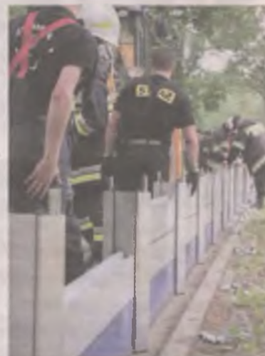
Jednym z elementów ćwiczeń było zainstalowanie specjalnych przesł, które w razie gwałtanego podnoszenia się stanu wody, pozwalają utrzymać żywioł w korycie rzeki.
