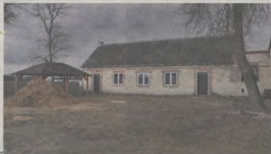
Przed budynkiem stoi już nowa altana. Kupa piasku obok niej wskazuje na to, że najprawdopodobniej to jeszcze nie koniec remontów.
