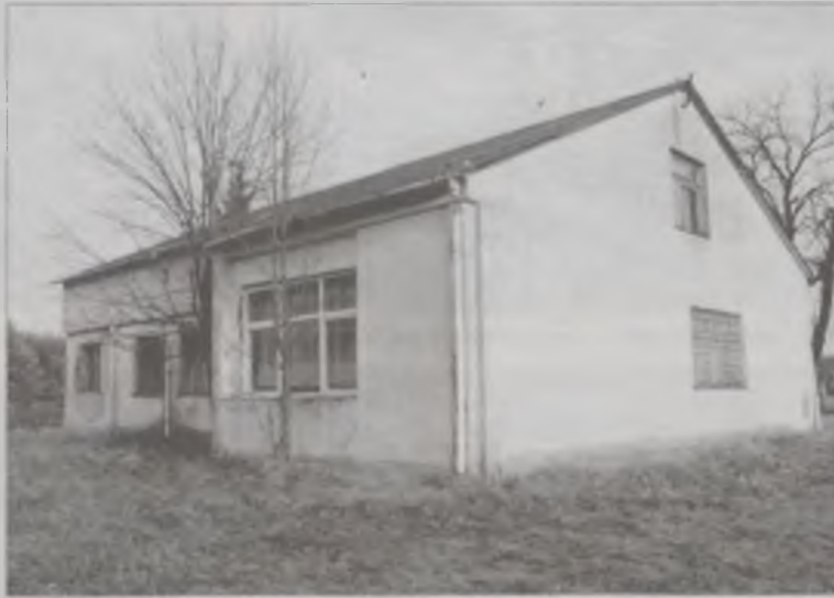
Budynek po szkole w Rzymsku ma zostać zaadoptowany na dom spokojnej starości.
