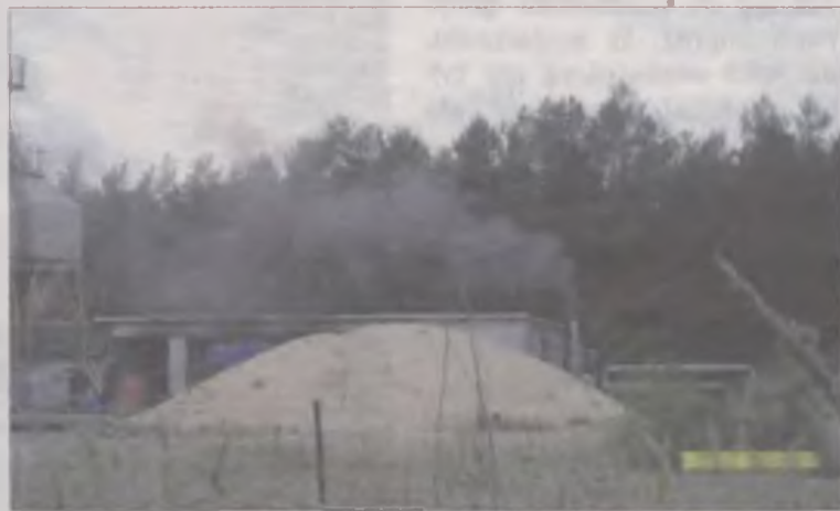
Nowy inwestor, jeszcze przed otrzymaniem decyzji wójta, rozpoczął prace przygotowawcze.
