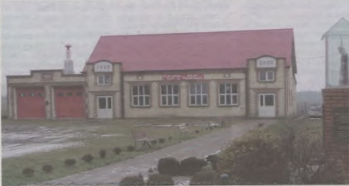
Remiza OSP w Roźniatowie, zbudowana z wapienia, którego pokłady znajdują się pod wsią.
