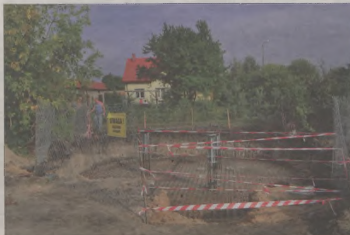
Fundamenty masztu wykopano 30 metrów od domu. Przez pierwszy tydzień roboty nie były zabezpieczone, kiedy zainteresował się tym nadzór budowlany, ogrodzono je siatką.
