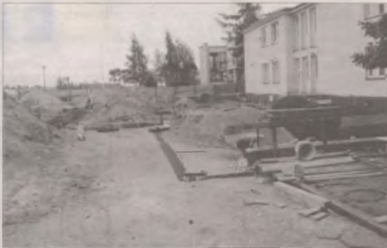
Dobudowane zostanie skrzydło od strony banku.
