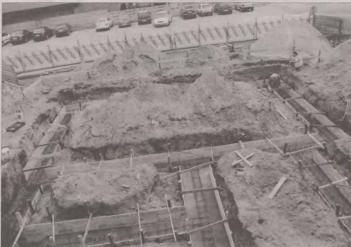
Trwają prace nad budową fundamentów.
