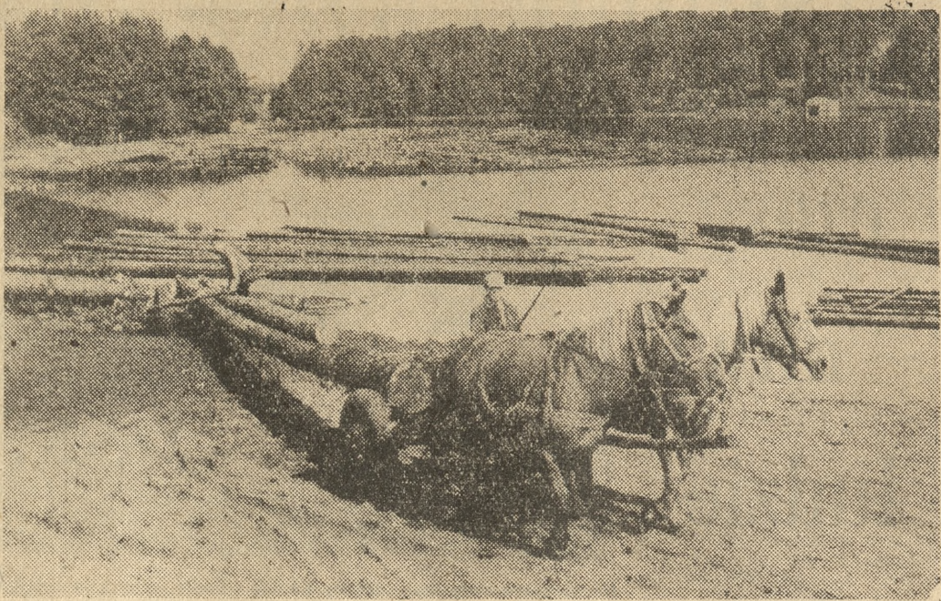
Splaw drewna budowlanego na Jeziorze Białym k. Augustowa.
