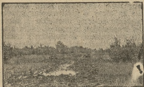
Droga przez mokradła, zbudowana ze ściętych krzaków.
