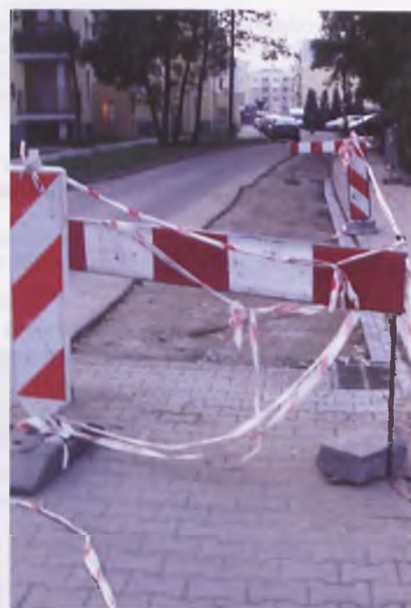
Prace remontowe na ulicach Lubonia
