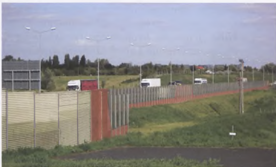
Istniejące ekrany akustyczne są niewystarczające i dopuszczalne normy hałasu są przekraczane
