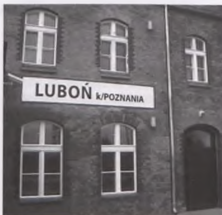
Zmodernizowany budynek lubońskiego dworca
