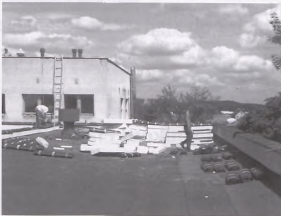
Dach budynku Szkoły Podstawowej nr 3
