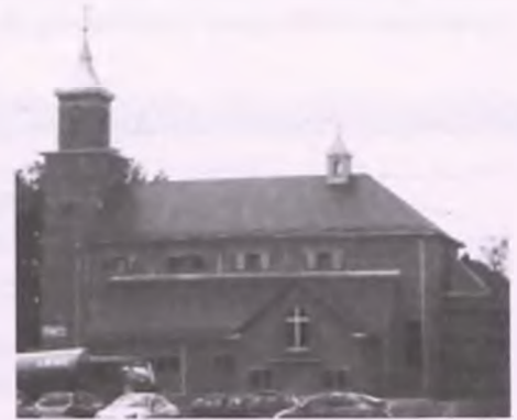
Nowy kościół przy ulicy Źródlanej
