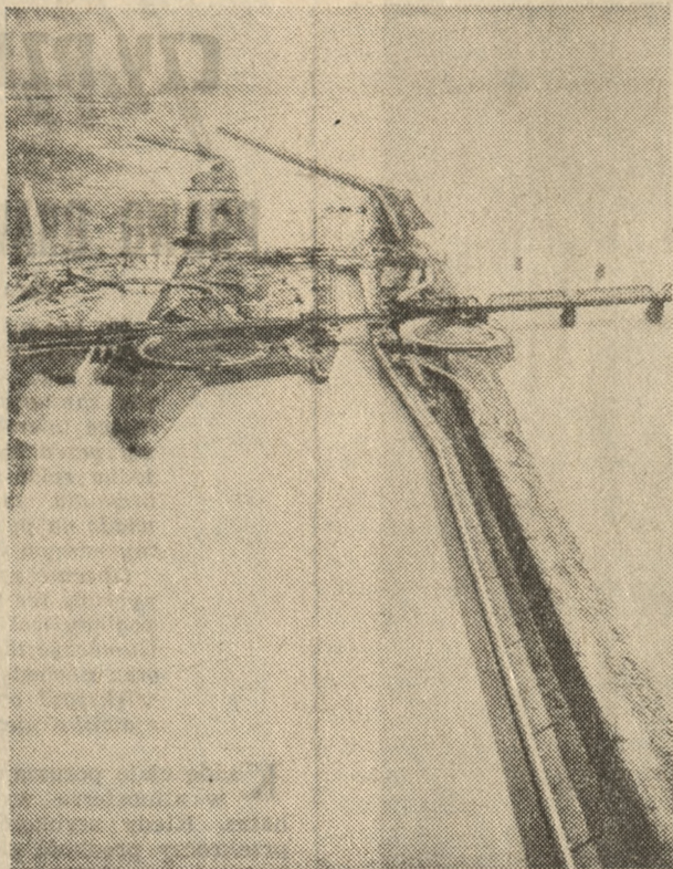
Sluzy kanału Welland omijającego wodospady Niagary. Kanał ten ma 8,2 m głębokości i do jego poziomu dostosowane są wszystkie kanały na rzece Św. Wawrzyńca. Kanał Welland łączy jezioro Erie z jeziorem Ontario.
